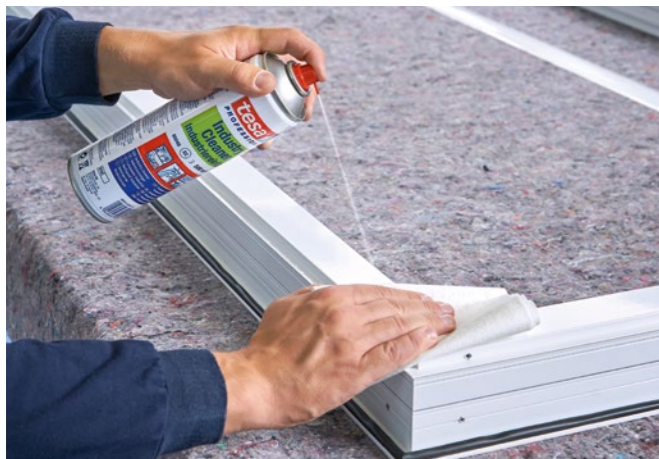
Reinigung von Hand mit einem Industriereiniger.
