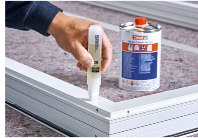
Aufbringen eines Promoters auf die zu verklebende Oberfläche.
