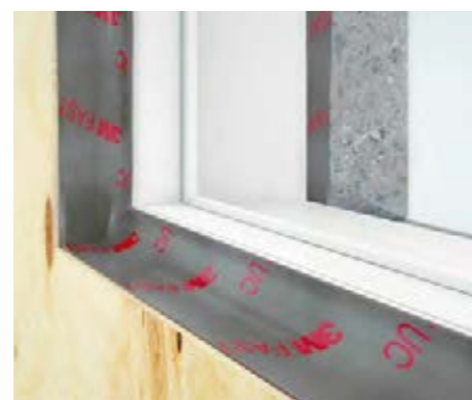
Mit hoher Klebkraft auf unterschiedlichsten Untergründen und effektiver Abdichtung gegen eindringende Feuchte, leistungsstark auch im Außenbereich.
